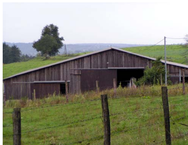
Insertion d'un bâtiment agricole dans le paysage - Moissannes, La Mareille
