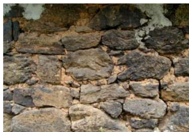
Mortier de terre - Sussac
