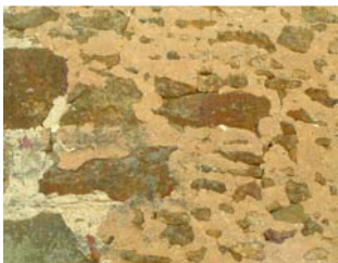
Enduit à "pierres vues" Cheissoux
