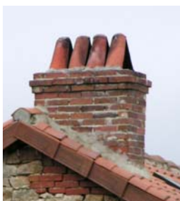
Souche de cheminée - Roziers-Saint-Georges
